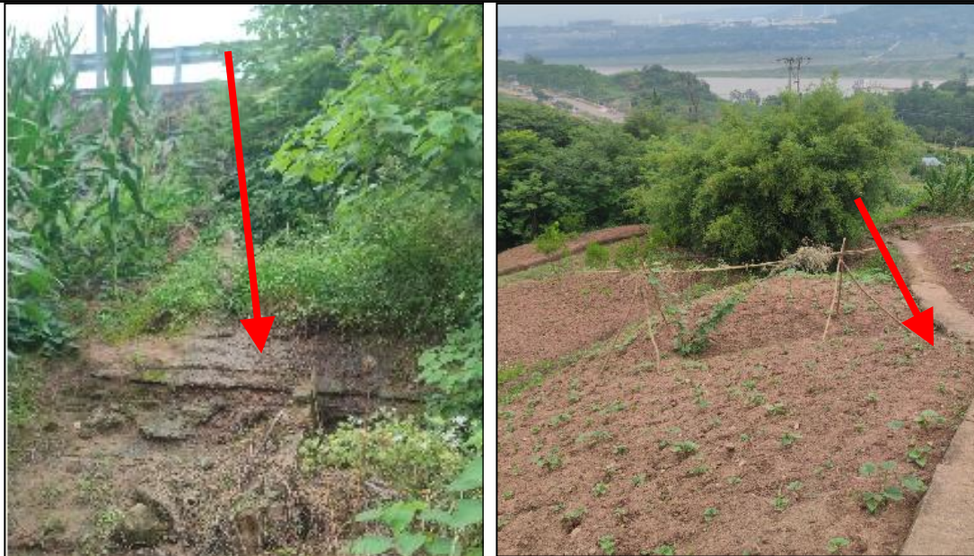
排洪沟起点现状
