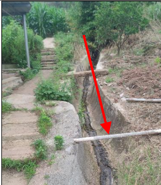
PCK0+278.515~PCK0+787 段 U 型排洪沟
