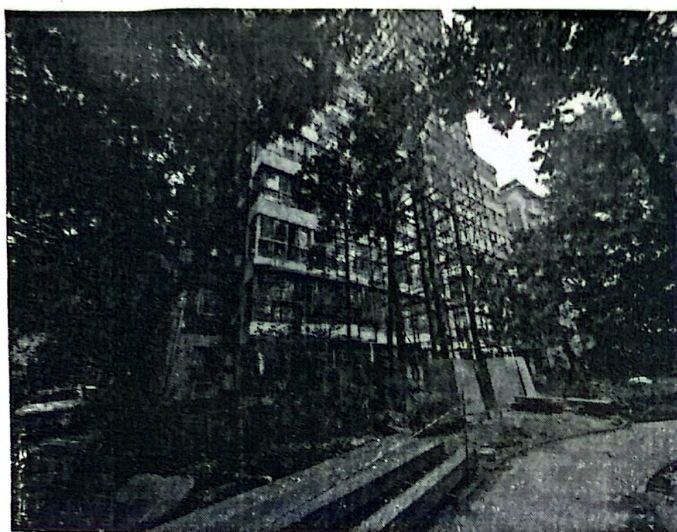
图 1-1 外观现状照片
