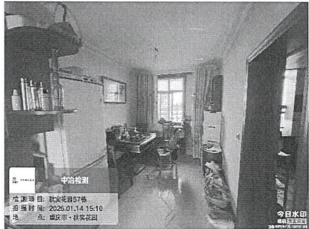
图 4-4：构件外观现状
