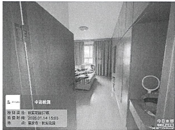
图 1-14：八层室内现状
