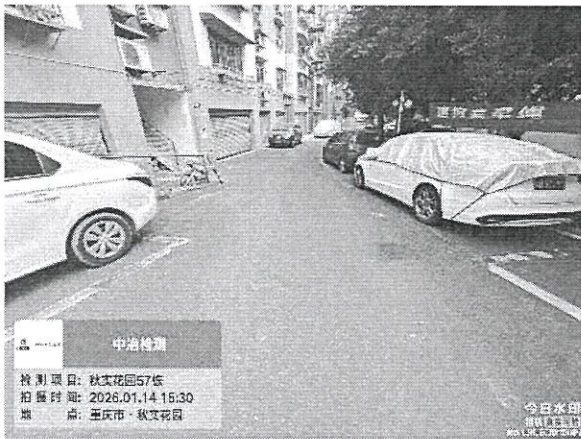
图 4-1：房屋正面场地现状
