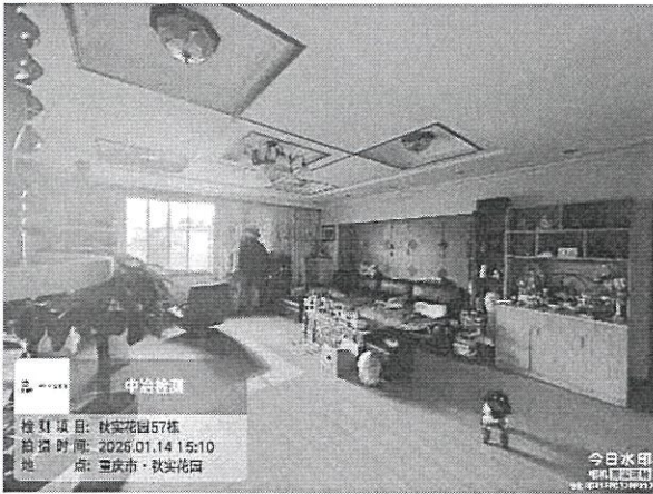
图 1-13：八层室内现状
