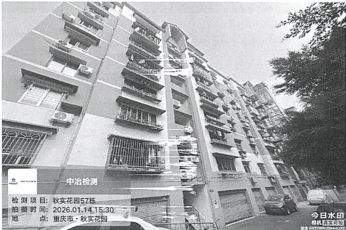
图 1-1：房屋立面现状
