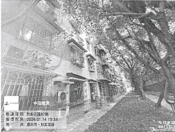
图 4-6：围护构件外观现状
