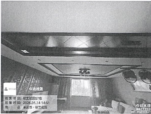
图 4-3：构件外观现状
