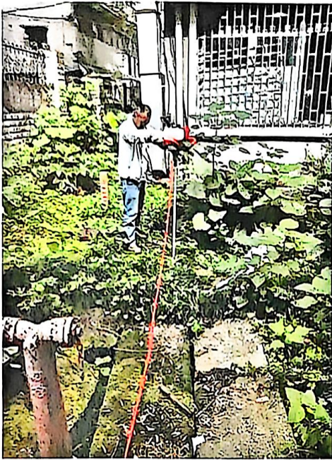
照片 1 电梯位置及现场钻探施工
